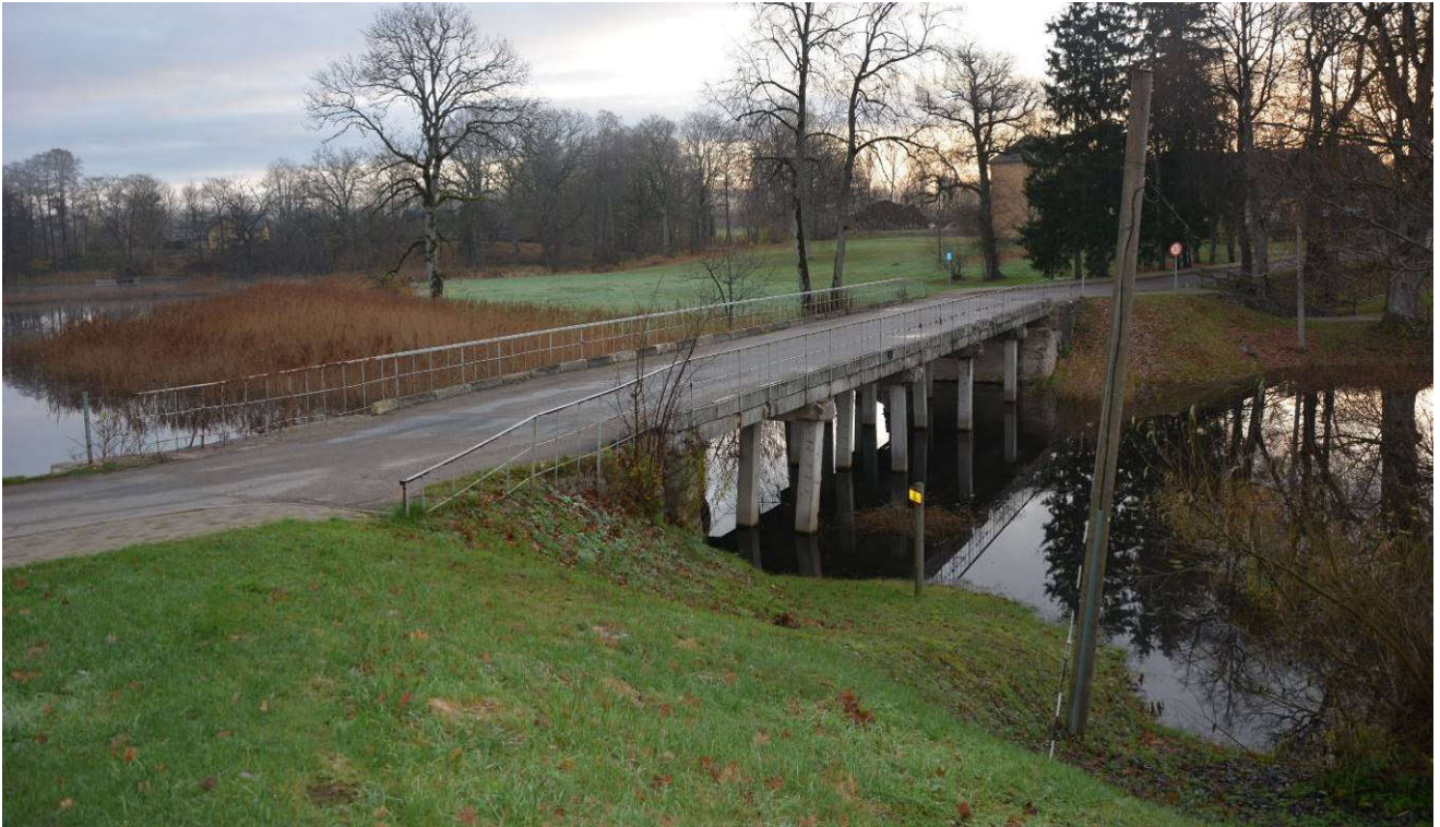
2.1. att. Esošā tilta kopskats. Augštece (skats estrādes virzienā)
