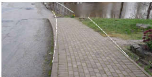
1.attēls. Esošās ietves savienojums ar tilta gājēju ietvi.
