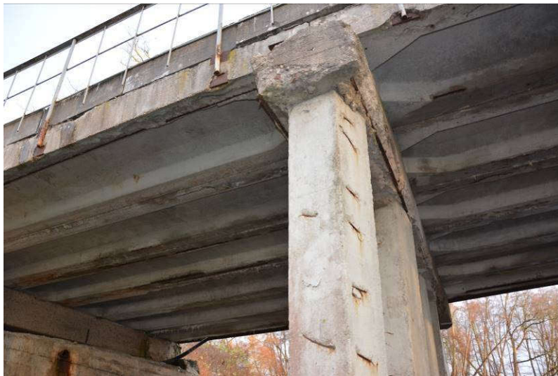
2.4.3. att. Balsts Nr.2, augštece. Uzkalas lejasdaļā atsedzies stiebrojums.
