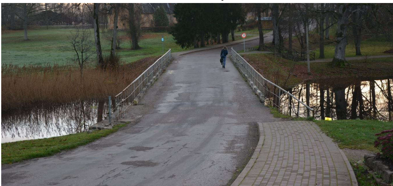
2.1.2. att. Brauktuves un labā krasta pieejas kopskats (skats estrādes virzienā). Trūkst ceļa zīmes Nr.906, Nr.907 un Nr.708 (ūdens šķēršļa nosaukums). Tilts bez gājēju ietvēm. Pārredzamība apmierinoša
