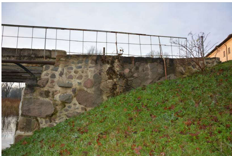
2.3.6. att. Balsta Nr.1 fasāde no lejteces puses. Komunikāciju aizsargcaurule (no tērauda) iebetonēta mūra konstrukcijā
