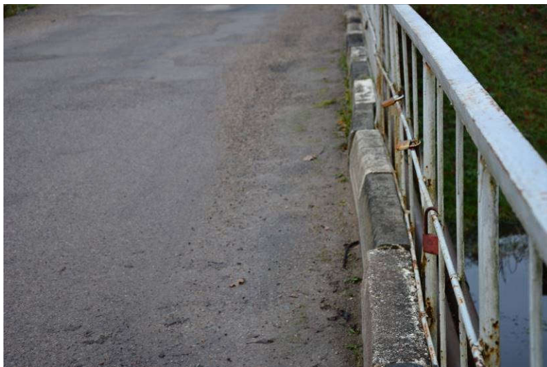
2.1.8. att. Betona apmales akmeņi izjukšanas stadijā (lejtece)
