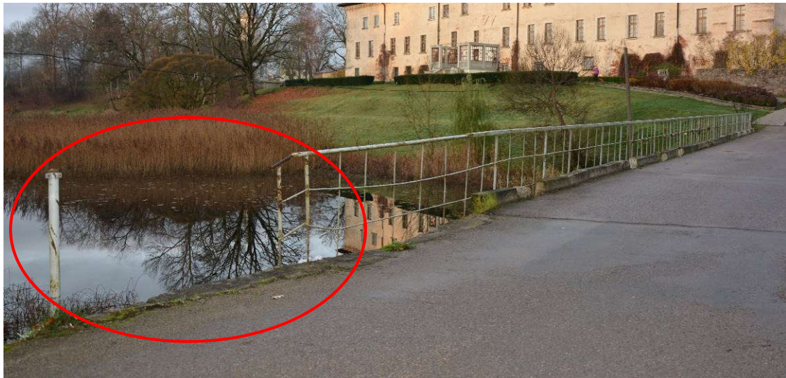
2.1.3. att. Trūkst margu posms virs atbalstsienas, trūkst ceļa zīme Nr.907 (augštece, labais krasts)
