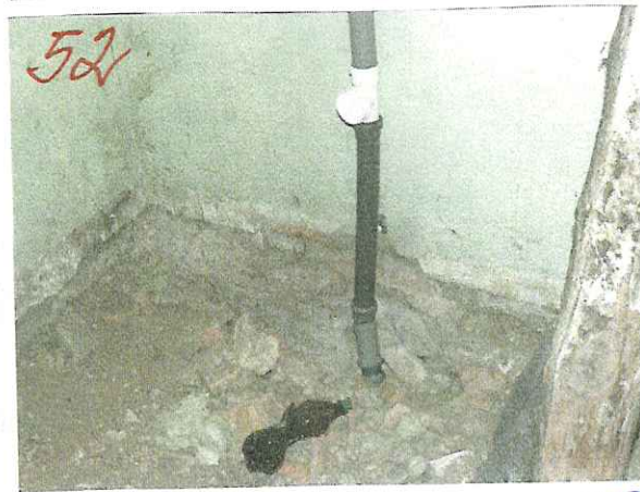
49 50 51 52 AUKSTĀ ŪDENS UN KANALIZĀCIJAS CAURU4VADI, VENTILI UN KĀRĀCI NOMAINĪTI TĪKAI AVĀRIJĀS VIETĀS.
