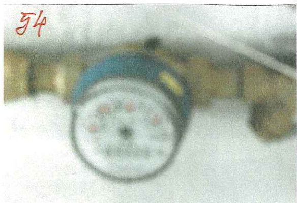
54 UZSTĀDĪTI INDIVIDUĀĻI AUKSTĀ ŪDENS PATĒRĪNĀ SKAITĪTĀJI
