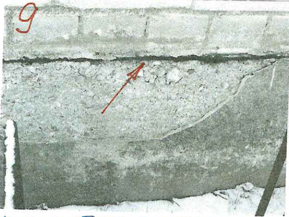
9 HIDROIZOLĀCIJA PĀ BŪVES PERIMETRU
