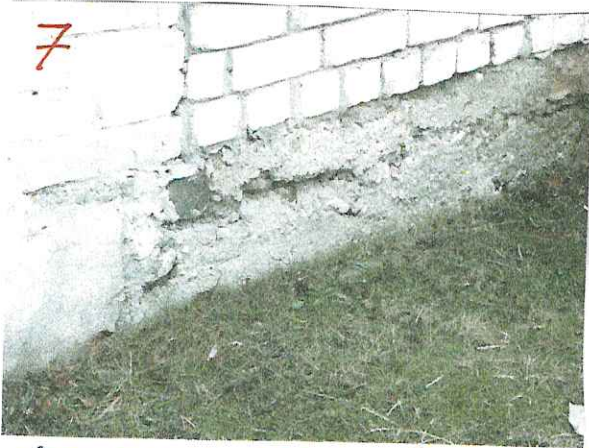
7 LENTVEIDA ARMĒNŪ/BETONA PAMATI. BETONA STIPRĪBA B15
