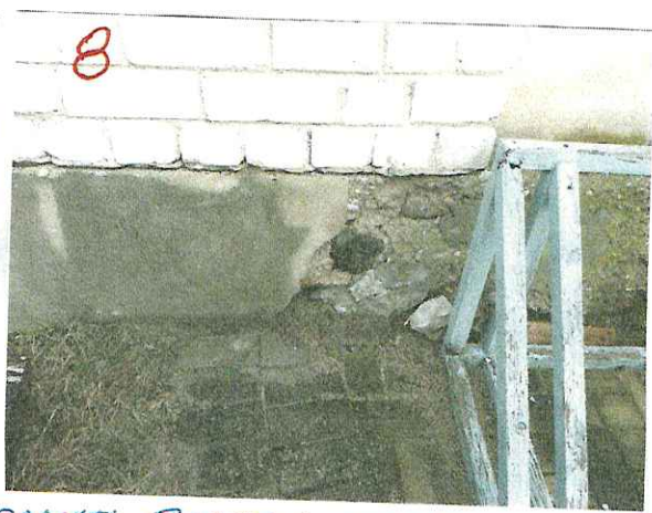
7 LENTVEIDA ARMĒNŪ/BETONA PAMATI. BETONA STIPRĪBA B15
